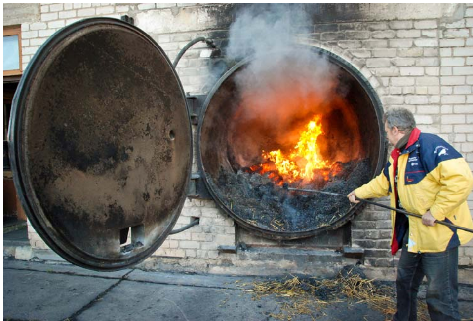
3 pav. Šiaudų ritinių deginimo pakūros bendras vaizdas
