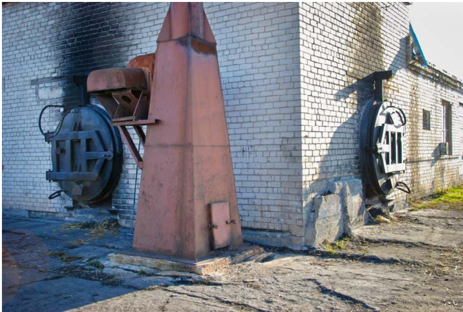
2 pav. Mokslinės – gamybinės įmonės UAB „Slengiai“ įrengto šiaudų ritiniais kūrenamo katilo su dviem pakūrom durys
